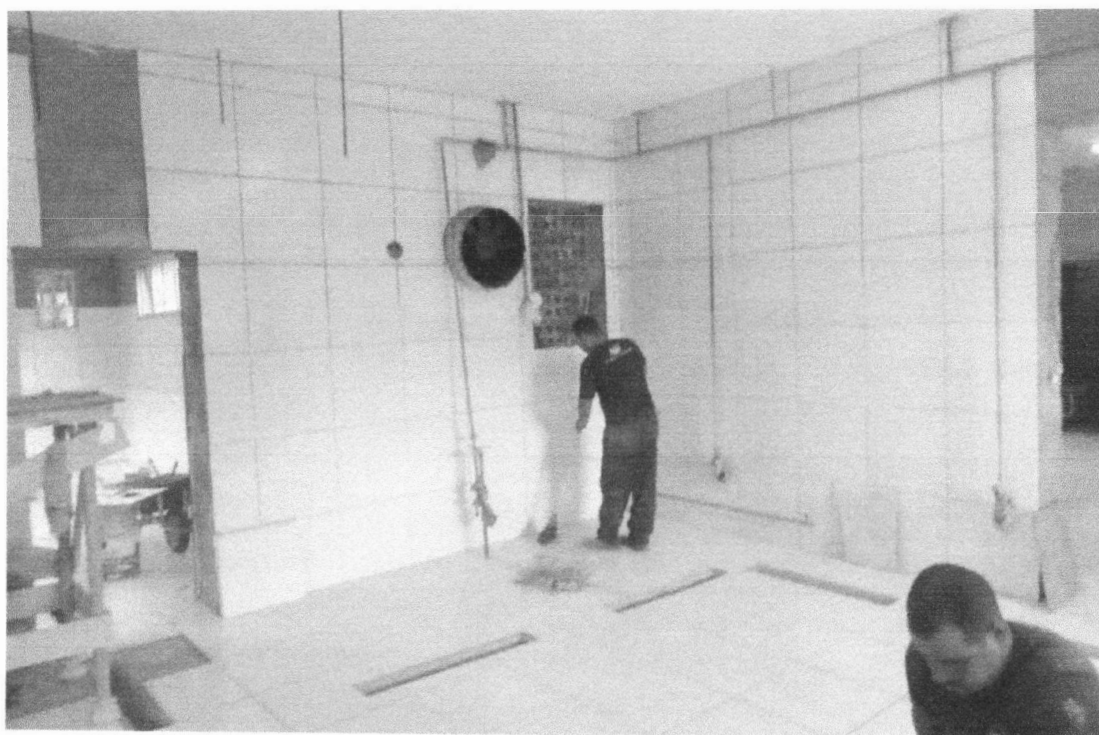
Foto 04 – Instalação de cerâmica;
