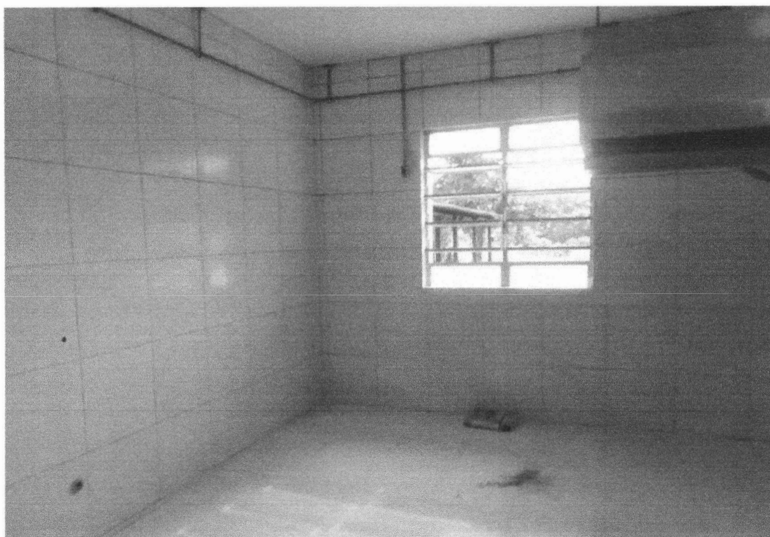
Foto 05– Instalação de cerâmica em paredes;
