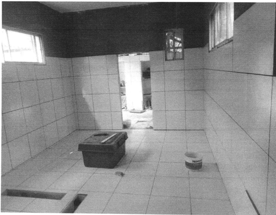
Foto 01 – Instalação de cerâmica em piso e parede;
