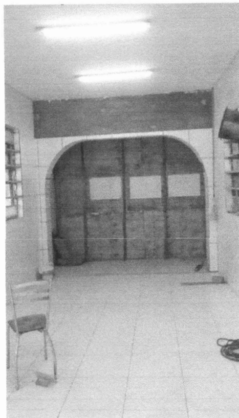
Foto 03 – Instalação de cerâmica e pintura do teto;
