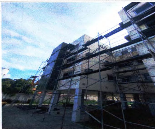
MOBILIZAÇÃO DE ANDAIMES PARA EXECUÇÃO
