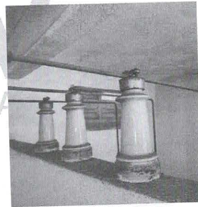
Foto 15 – Barramento de MT – Apresentando oxidação e pintura em desacordo com a NBR
