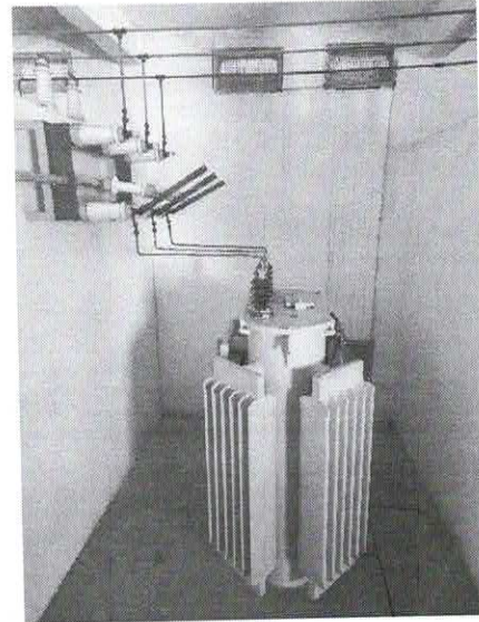
Fotos 13 e 14 – Transformador de energia – Limpeza geral e eliminação de resíduos externos
