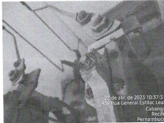
Foto 01 – Disjuntor de Média Tensão – Partes fixas e móveis com sinais de oxidação
