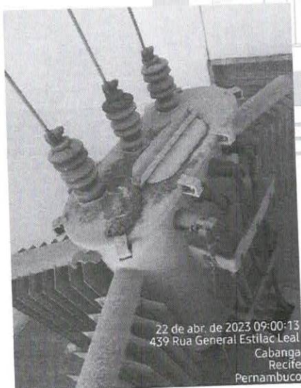
Fotos 08 e 09 – Transformador de energia – Excesso de poeira e agentes externos
