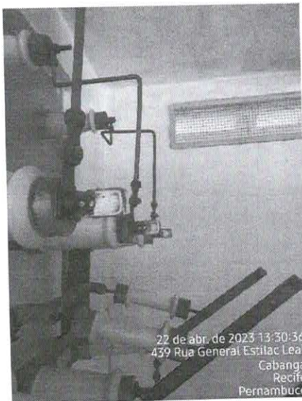
Fotos 06 e 07 – Chave Seccionadora MT – Limpeza geral e lubrificação com pasta antioxidante
