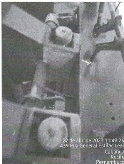
Fotos 03 e 04 – Disjuntor de Média Tensão – Bobinas de comando e intertravamento comprometido
