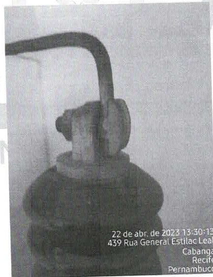
Fotos 18 – Barramento de MT – Reaperto e limpeza das conexões dos barramentos
