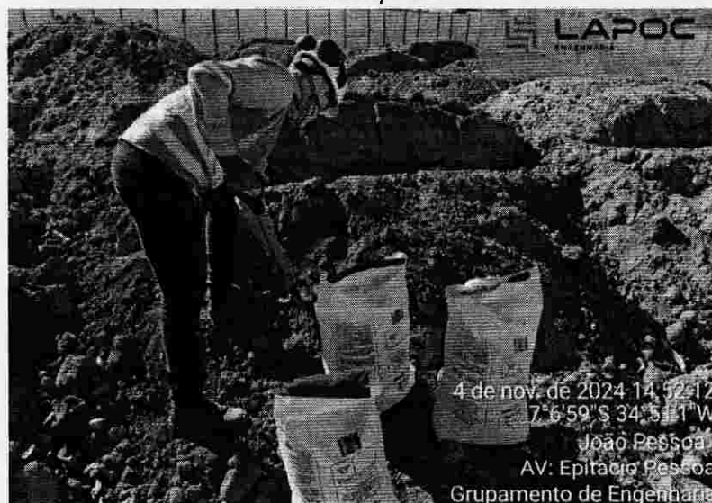
FOTO 04 – Coleta da amostra para ensaios de caracterização em laboratório, para a obra de terraplenagem da construção do rancho do 1º Grupamento de Engenharia, na cidade de João Pessoa/PB.
