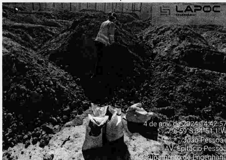
FOTO 03 – Coleta da amostra para ensaios de caracterização em laboratório, para a obra de terraplenagem da construção do rancho do 1º Grupamento de Engenharia, na cidade de João Pessoa/PB.
