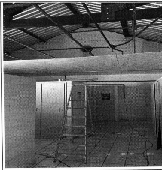
FOTO 12 FORNECIMENTO DE FORRO PVC
