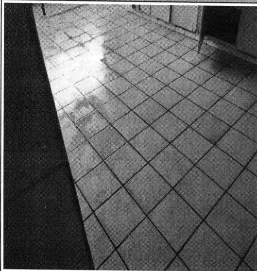
FOTO 1 LIMPEZA DE PISO CERÂMICO
