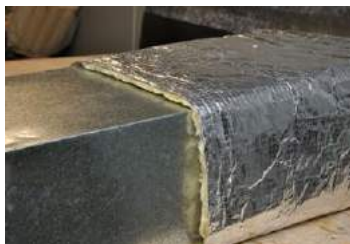
Figura 13 – Isolamento em manta de lã de vidro
