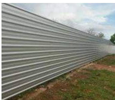
Figura 3: Tapume com telha metálica trapezoidal
