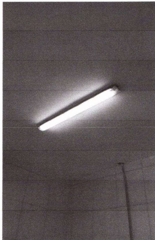
Foto 06 – Aplicação de pintura em teto;
