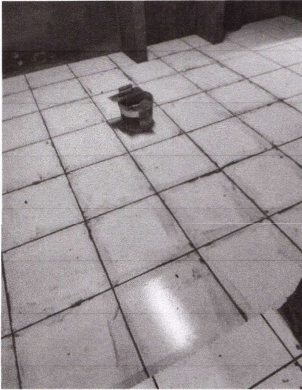
Foto 02 – Instalação de cerâmica;
