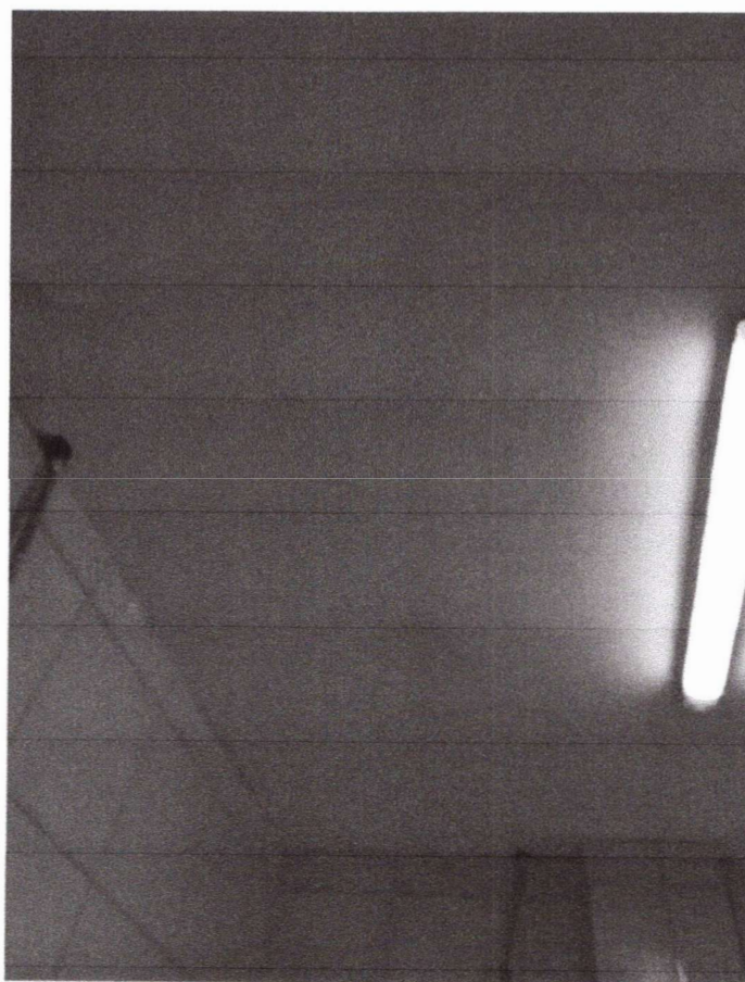
Foto 01 – Pintura de teto;
