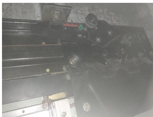
Figuras 6 – Sensor limitador e Operador de Porta
