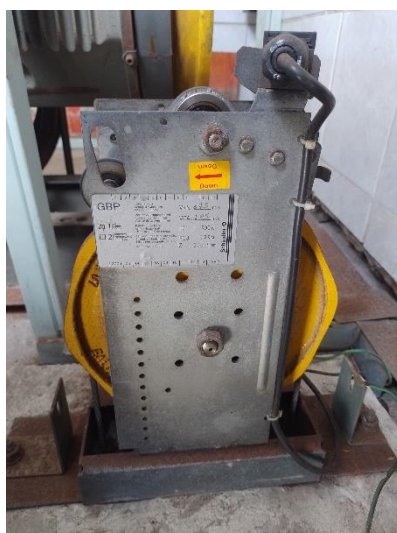
Figuras 5 – Máquina de tração, limitador de Velocidade e Freio de Segurança
