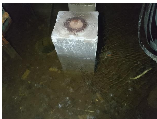
Figura 7 – Cabina (Topo) e Poço
