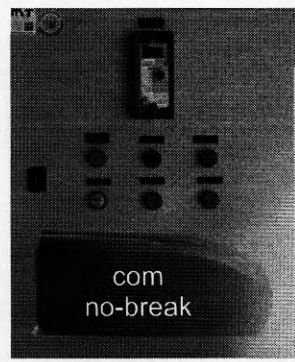
Painel de proteção geração/rampa com relé URP 6100 Pextron proteção na média tensão e no-break senoidal
