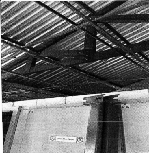
FOTO 31 ABRICAÇÃO E INSTALAÇÃO DE TESOURA INTEIRA
