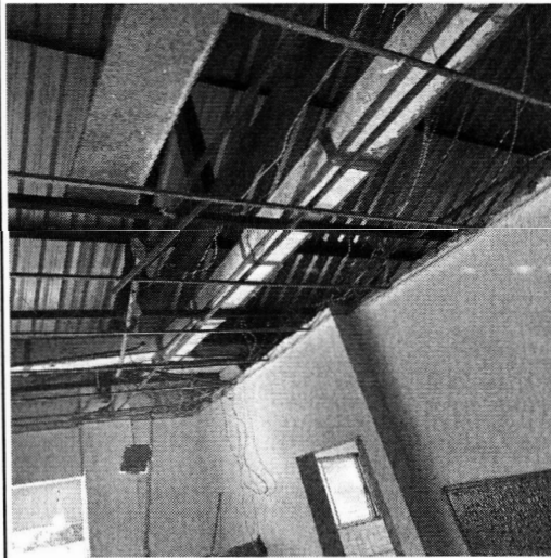
FOTO 28 REMOÇÃO DE ELETROCALHA
