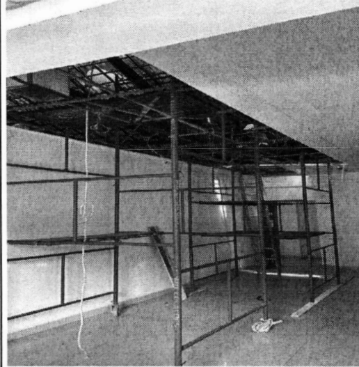
FOTO 2 MONTAGEM E DESMONTAGEM DE ANDAIME
