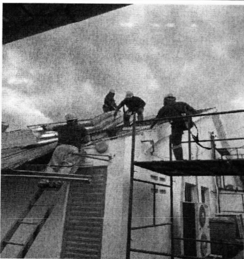
FOTO 37 DEMOLIÇÃO DE ALVENARIA
