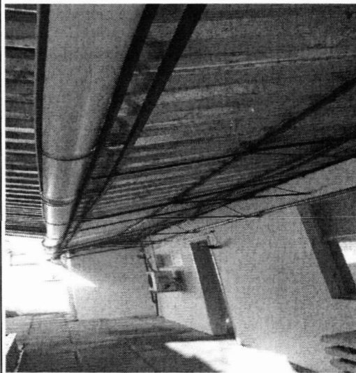
FOTO 20 REMOÇÃO DE TRAMA METÁLICA
