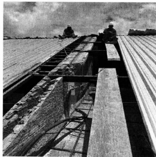
FOTO 36 DEMOLIÇÃO DE ALVENARIA
