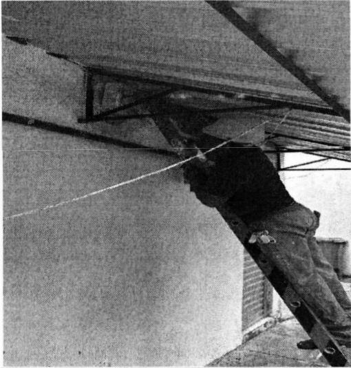
FOTO 9 APLICAÇÃO MANUAL DE PINTURA
