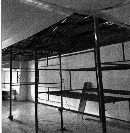
FOTO 4 LOCAÇÃO DE ANDAIME
