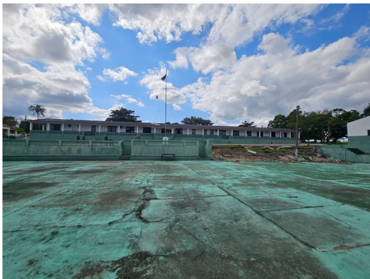
Visão Global do Muro de Arrimo - 22/07/2024
