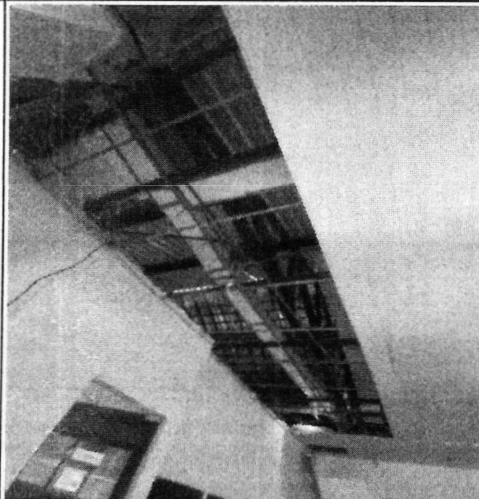
FOTO 14 FABRICAÇÃO E INSTALAÇÃO DE TESOURA INTEIRA
