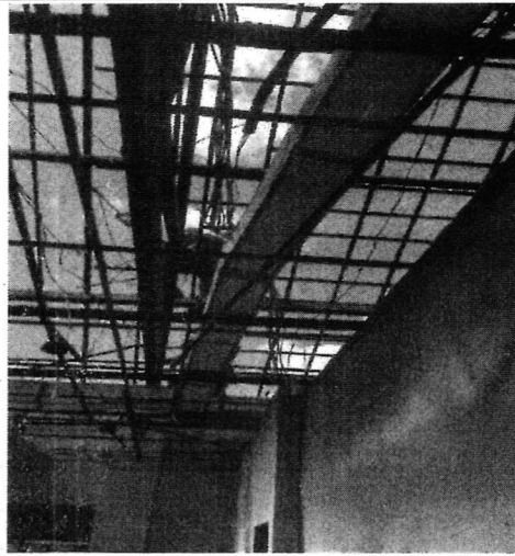
FOTO 8 REMOÇÃO DE TESOURA DE MADEIRA
