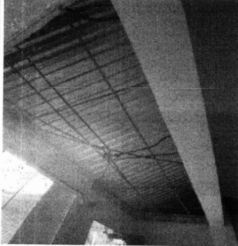
FOTO 10 REMOÇÃO DE FORRO PVC
