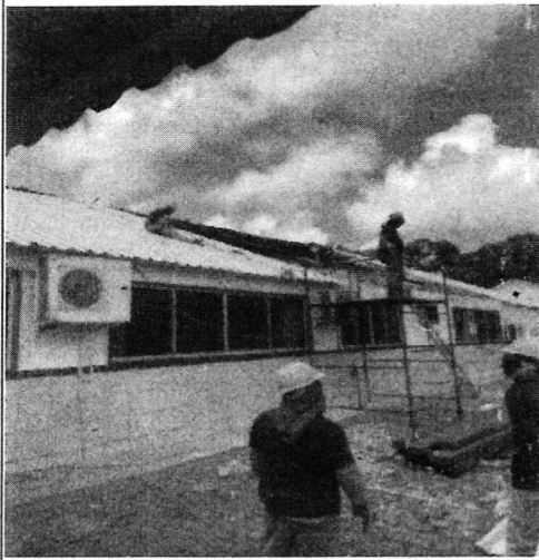
FOTO 7 REMOÇÃO DE TELHAS
