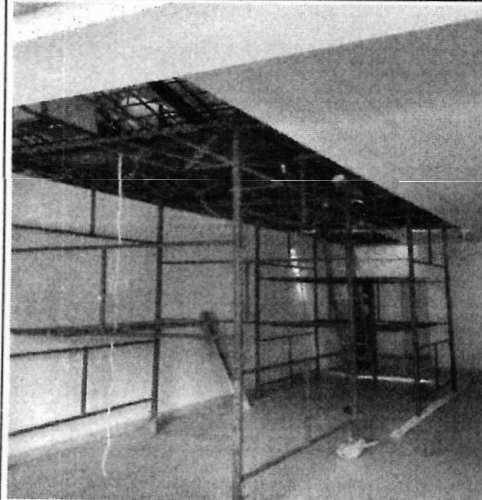
FOTO 2 MONTAGEM E DESMONTAGEM DE ANDAIME
