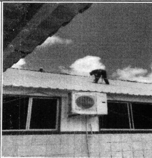
FOTO 18 TELHAMENTO COM TELHA METÁLICA
