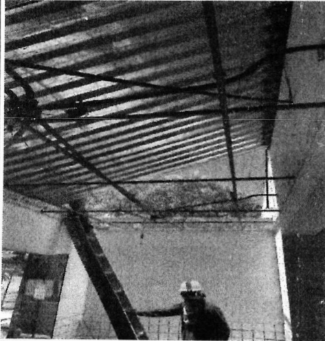
FOTO 9 REMOÇÃO DE TRAMA DE MADEIRA
