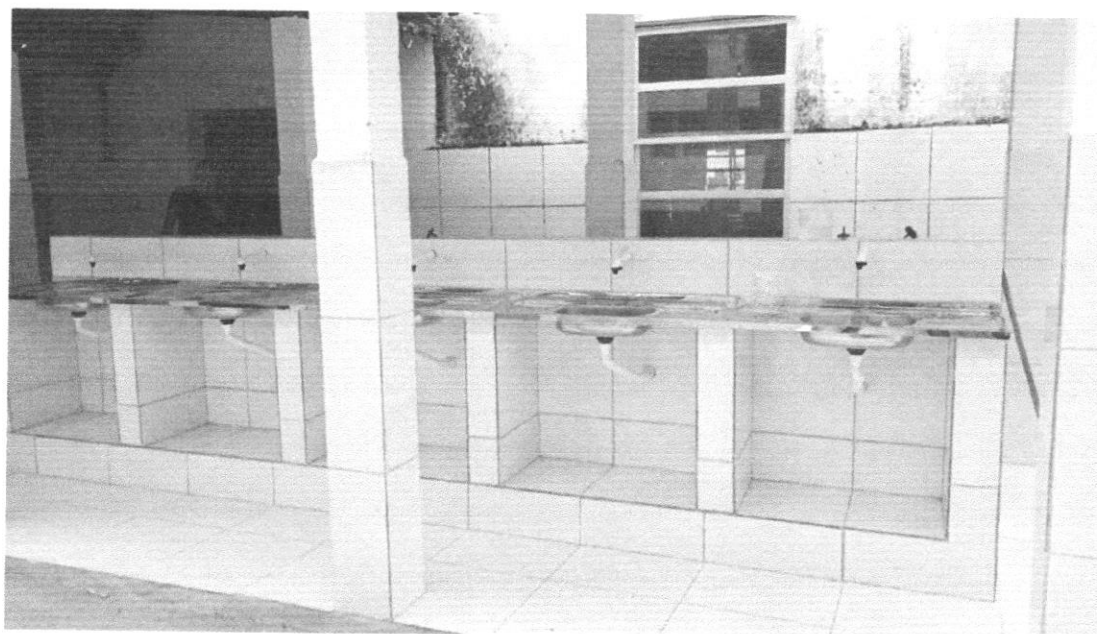
Foto 01 – Revestimento de parede;
