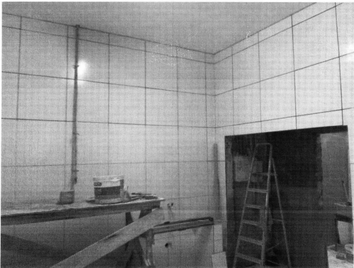
Foto 01 – Instalação de revestimento de parede;
