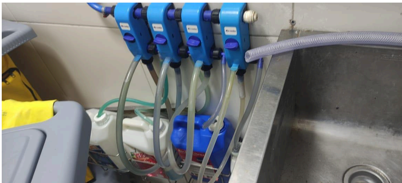
Foto x: local de diluição de saneantes utilizados na limpeza do estabelecimento, no DML.
