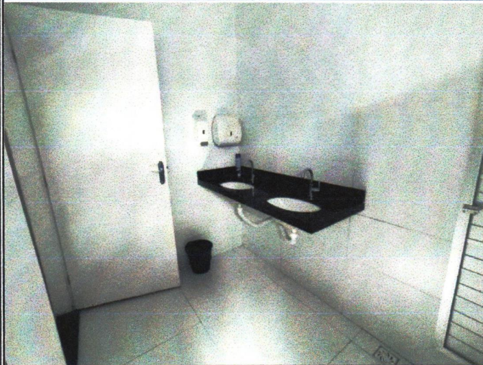
ÁREA INTERNA BANHEIRO MASCULINO
