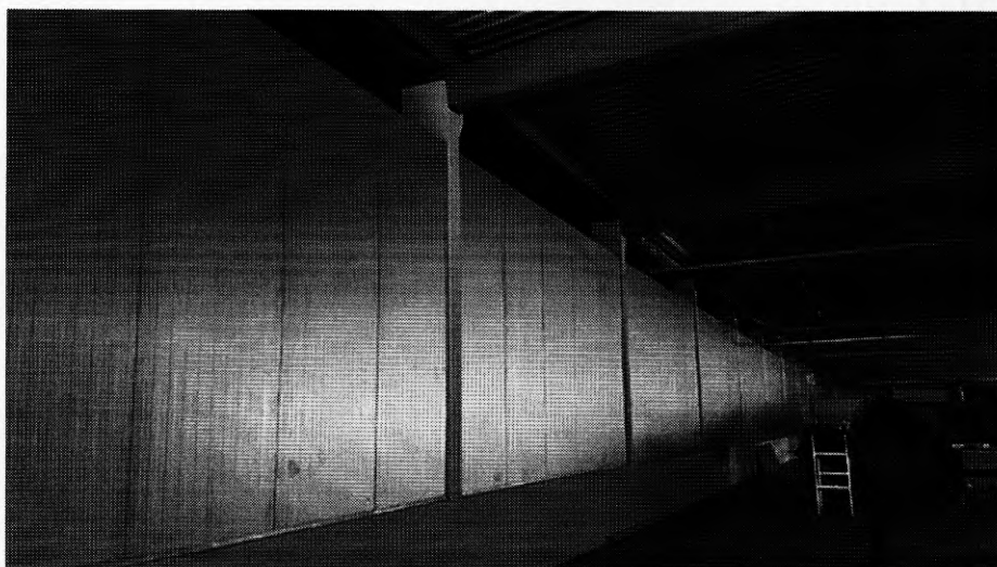
Figura 1 - Exemplo de aplicação de painel termo isolante para fechamentos verticais.
