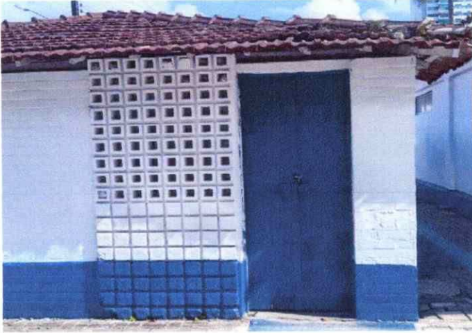
Fig. 01 - Fachada 1 - destaque da porta de acesso
