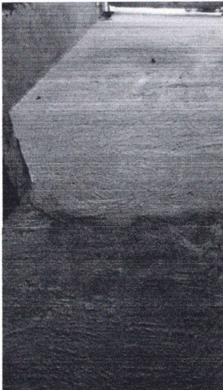
Foto 03 – Execução de contrapiso;
