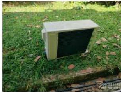
8-HT - Quarto 01 Agratto 18K N/A Instalação 09° 38' 7.7" S 35° 44' 6.0" W - 10/09/2025 14:26
