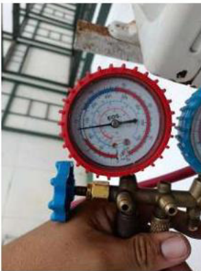
3-Quartel Alojamento Cabos e Soldados Elgin 30.000 Btus Reinstalação e Carga de gás completa R410 25/09/2025 16:06
