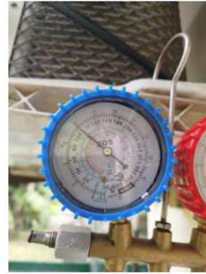
8-HT REFEITÓRIO CONSUL 18K CONVENCIONAL NECESSÁRIO FAZER COMPLEMENTO DE FLUIDO ANTES 24/09/2025 20:23
