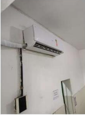
1-Quartel Alojamento Cabos e Soldados Elgin 30.000 Btus Reinstalação e Carga de gás completa R410 25/09/2025 16:06
