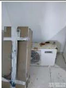
9-HT - Quarto 01 Agratto 18K N/A Unidades desinstaladas 09° 38' 8.7" S 35° 44' 6.0" W - 10/09/2025 15:46
