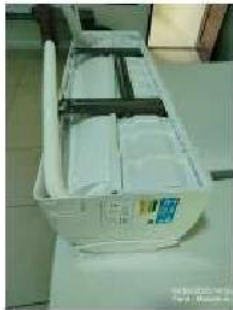
7-HT - Quarto 01 Agratto 18K N/A Instalação 09° 38' 8.7" S 35° 44' 6.0" W - 10/09/2025 14:26
