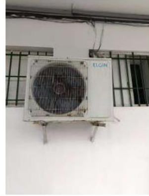
2-Quartel Alojamento Cabos e Soldados Elgin 30.000 Btus Reinstalação e Carga de gás completa R410 25/09/2025 16:06
