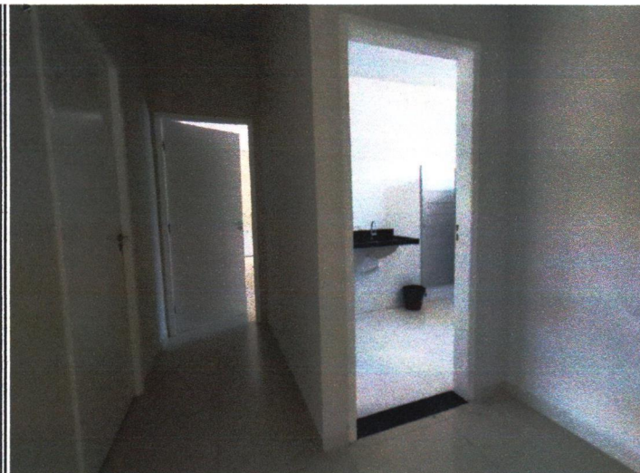
BANHEIROS E ACESSO ÀS SALAS
