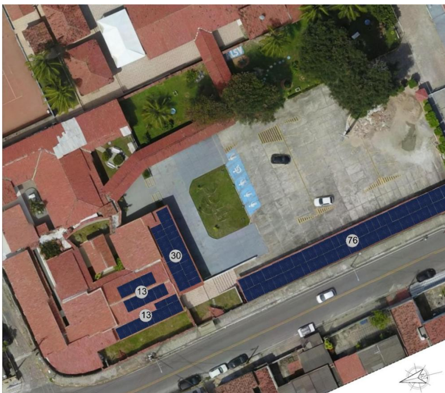
Imagem 01 - Foto aérea do Hotel de Trânsito Chapéu de Couro com a implantação das placas solares nas cobertas.
